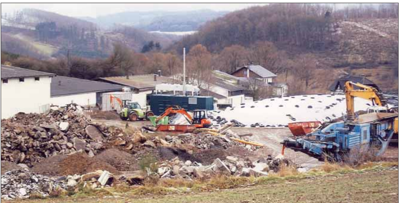
Umfangreiche Baumaßnahmen hinter dem Hof Sternberg. Bildmitte: das Blockheizkraftwerk
