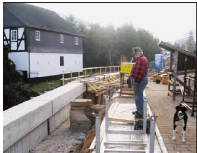
Die Twienemauer ist fast fertig.
