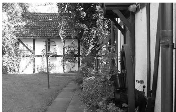
Der Nebeneingang des Hauses an der Nordseite
