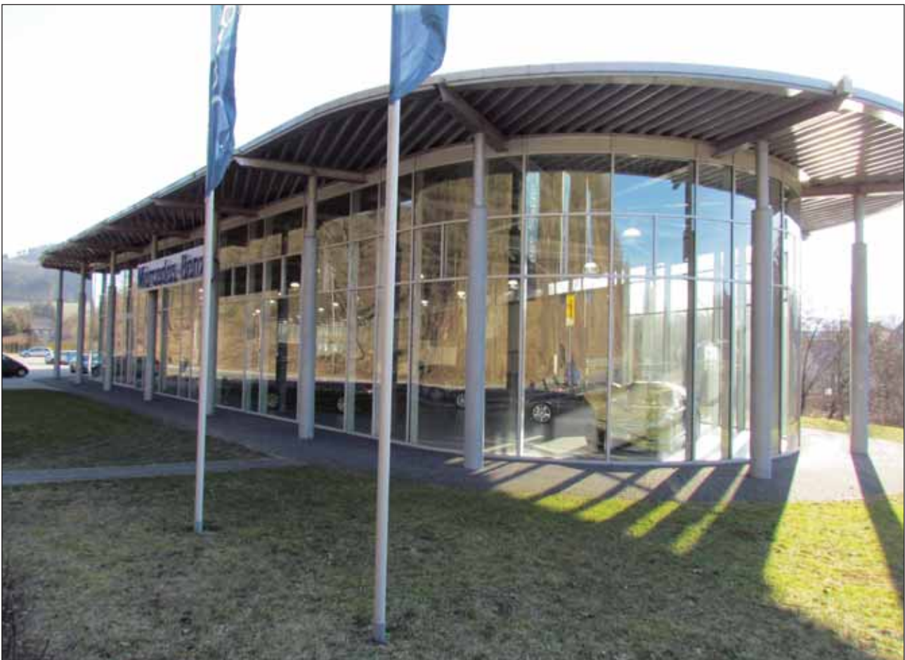
Ausstellungshalle an der B 55, Trockenbrück
