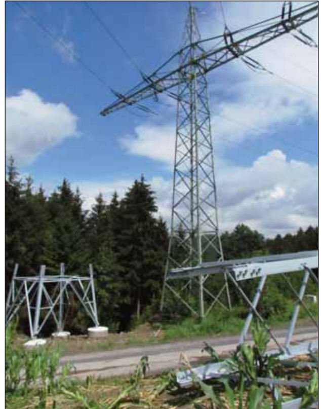
Die Masten stehen
