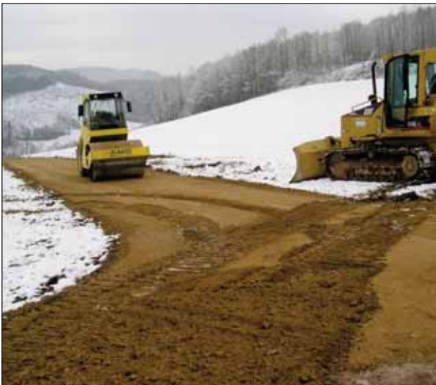
Erschließungswege für den Stromleitungsbau auf dem Kreuzberg
