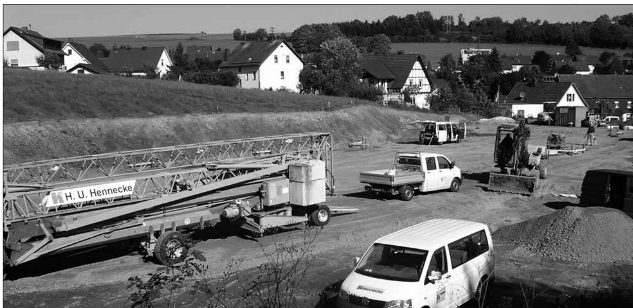
Baubeginn des neuen Feuerwehrhauses
