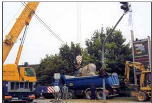
Ein gewaltiger Kran hievte den Kalksteinblock an seinen Platz am Ortseingang aus Richtung Elspe.
